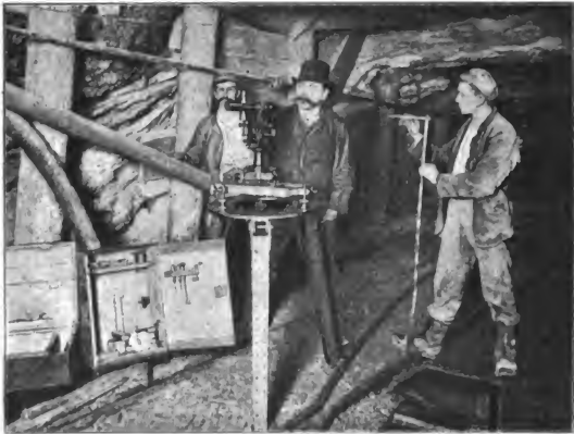
Fig. 10. Vermessungsarbeiten im Tunnel.
